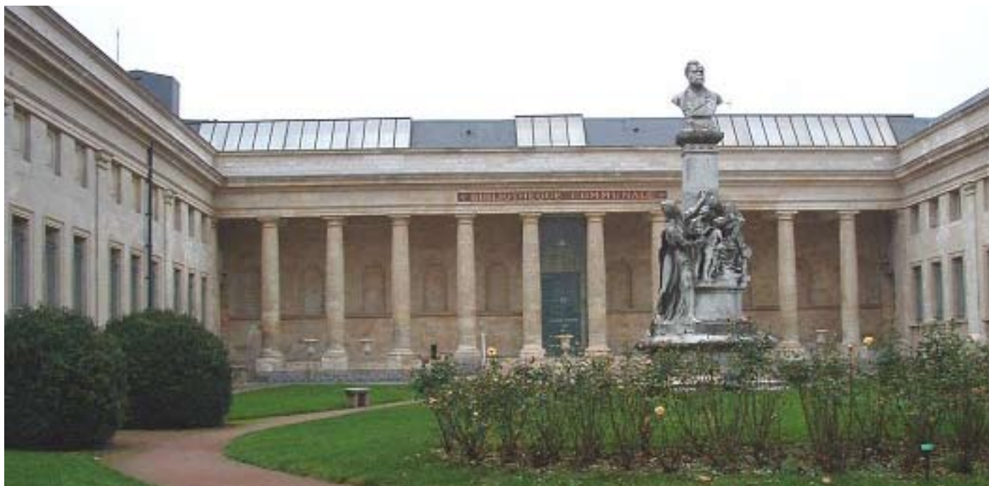
Patio de la biblioteca Municipal «Louis Aragon» ubicada en la ciudad de Amiens.
